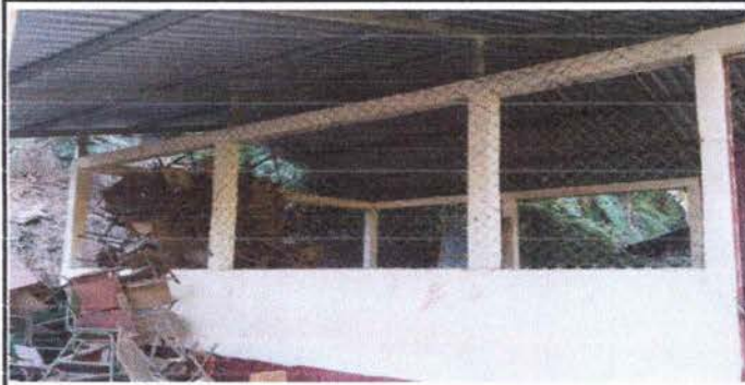
Foto 1: Instalacion de balcones. Modulo 2
